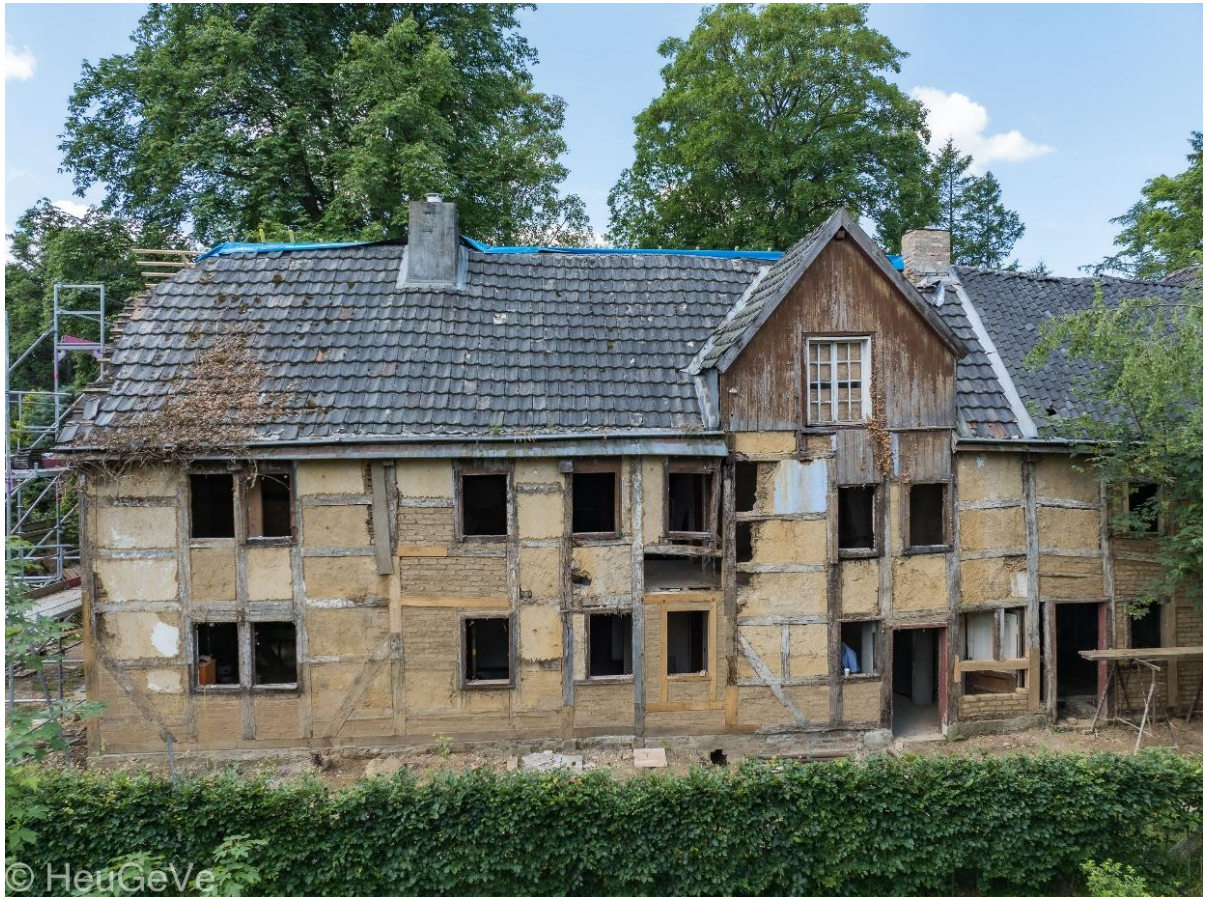
Die Rückseite während der Reparatur: neue Balken, erneuerte Lehmfücher etc.
