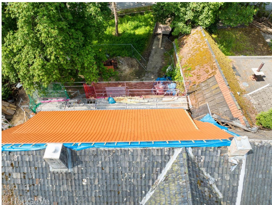
Das neu gedeckte Dach
