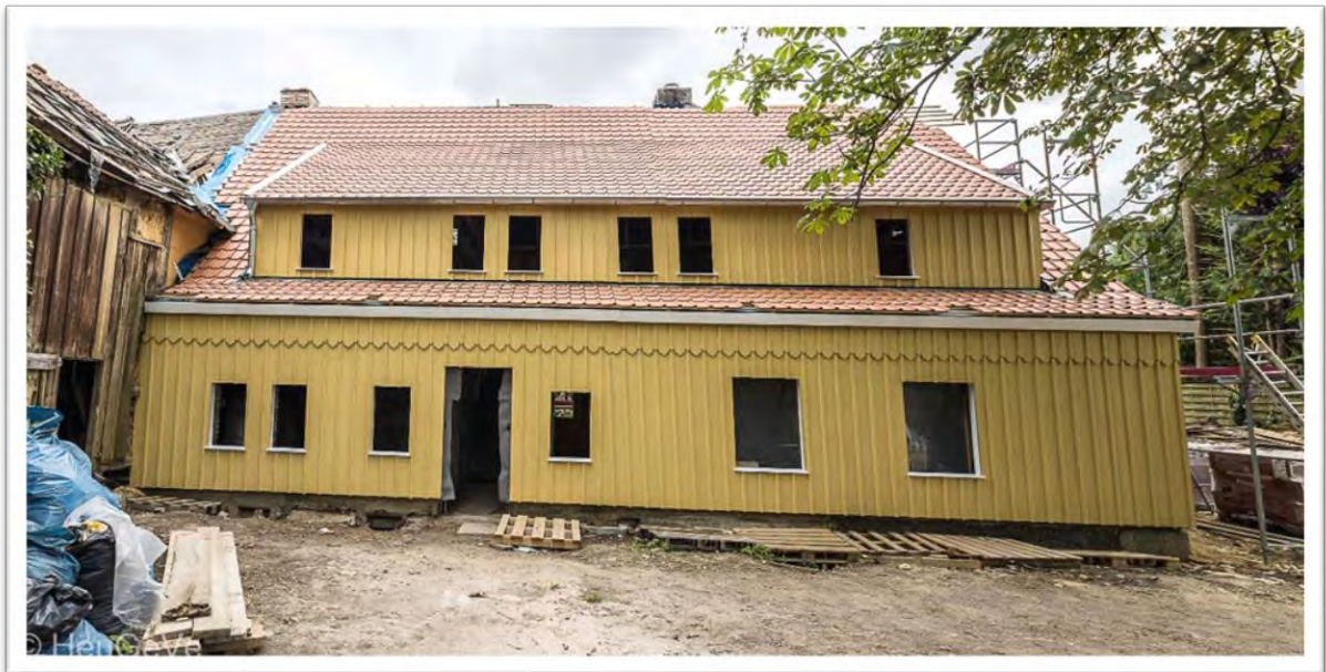
Die Frontansicht der „Alten Weberei“ mit der renovierten Fassade, der wiederaufgebauten vorderen Dachgaube und dem frischgedecktem Dach mit klassischen Raerener Ziegeln.
