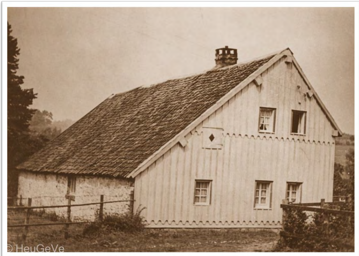
Das alte Haus Schmitz, an der Ecke, wo der Stockläger in den Rommelweg mündet (Abriss im 20. Jh.), Foto 1928
