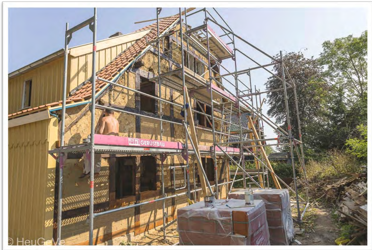
Noch wird das Gerüst benötigt: Man erkennt das Fachwerk des Giebels mit seinen Lehmfächern und dem teilweise erneuerten Balkenwerk, das gerade fachgerecht, mit der vom Denkmalschutz genehmigten Farbe, gestrichen wird.
