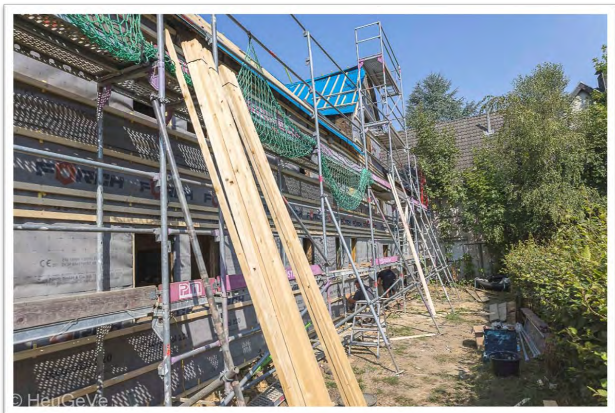
Auch die Rückseite und das hintere Dach sind in Arbeit. Wir hoffen, dass wir am Tag des Richtfestes weitere Fortschritte gemacht haben werden.
