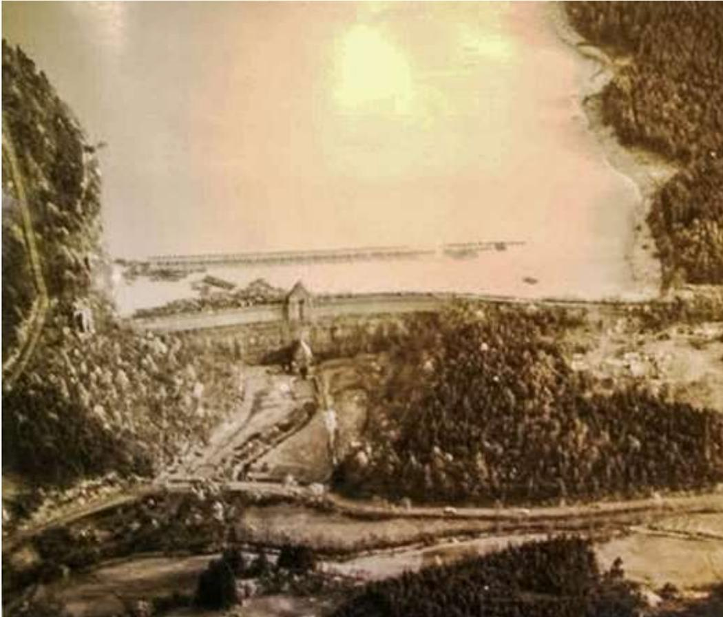
Die Mauer der Dreilägerbachtalsperre im 2. Weltkrieg, man erkennt das Torpedonetz vor der Mauer.
