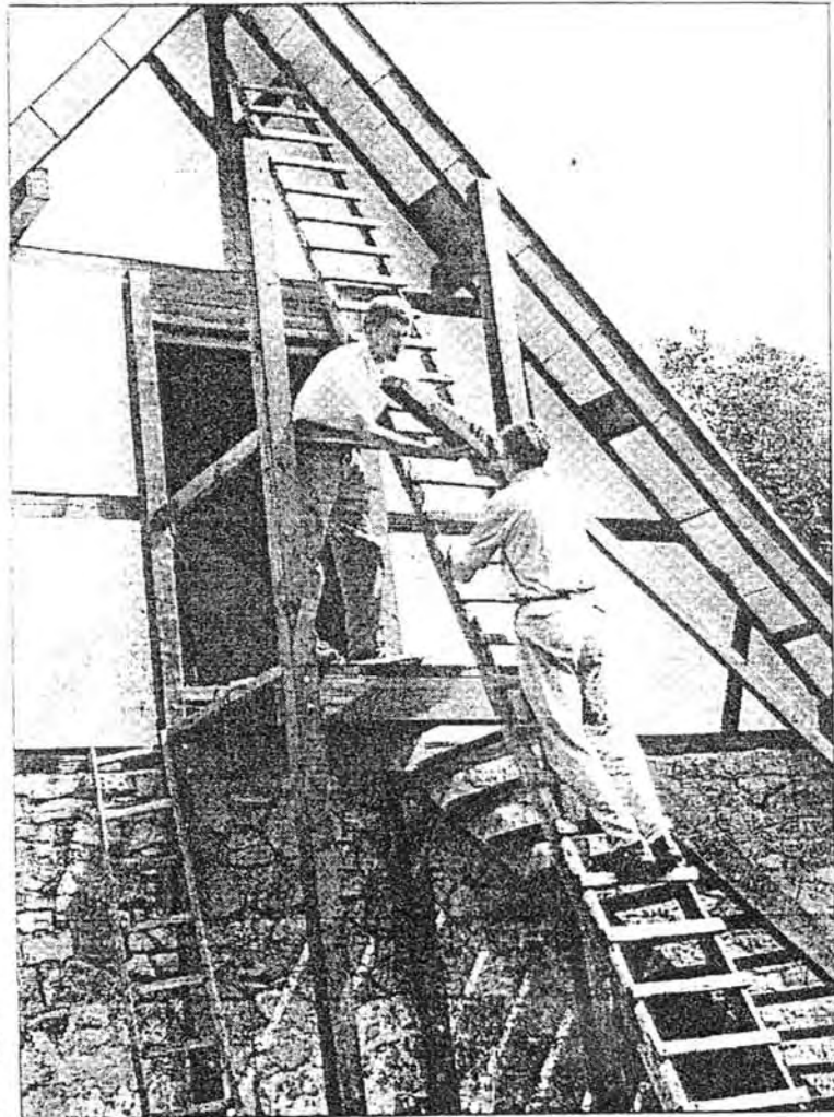
Gute Arbeit: Die Treppe an einem Nebengebäude wurde unter der Leitung von Bruder Werner erneuert und bildet einen stabilen Aufgang.
