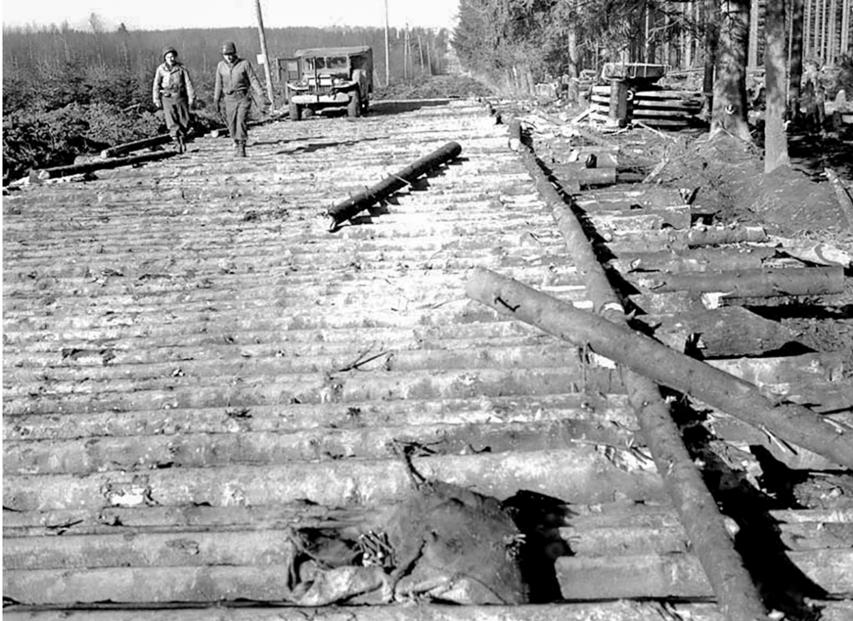
Die Raerener Straße am 12. Feb. 1945: Sie war am Ende des 2. WK eine der Hauptzufahrtsstraßen für den Nachschub der Alliierten und war eigentlich unbefahrbar. Um das zu verbessern, baute man einen riesigen Knüppeldamm.
