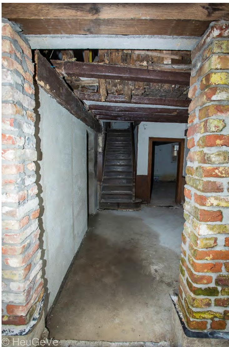
Blick von der Haustüre: neue Kellerdecke mit Balkenfundamenten
