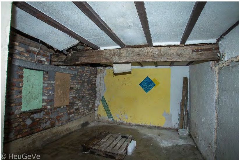
Blick in den linken Innenraum mit erneuertem Deckenbalken
