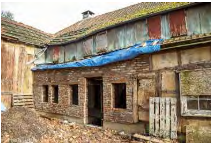
Die neue „Feldbrandsteinmauer“ zur Balkenabstützung
