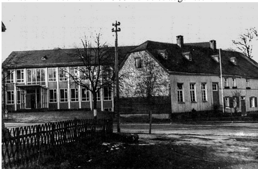
Der Neubau der ev. Grundschule (links) und die alte Volksschule (rechts), Foto ca. 1954:
