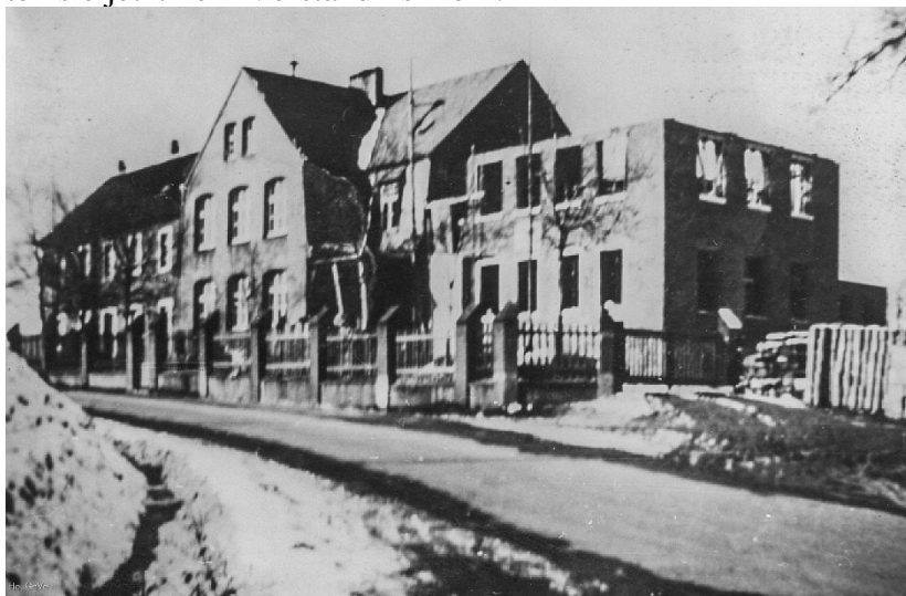
Die Baustelle an der kath. Volksschule, 1951
