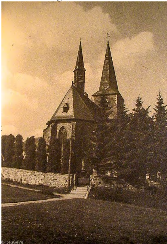
Undatierte Aufnahme der Konzener Pfarrkirche St. Peter, sie wurde 1160 ursprünglich als romanische Säulenbasilika erbaut. Nach Zerstörungen im 2. WK wurde St. Peter ab 1949 mehrfach umgebaut. 7
