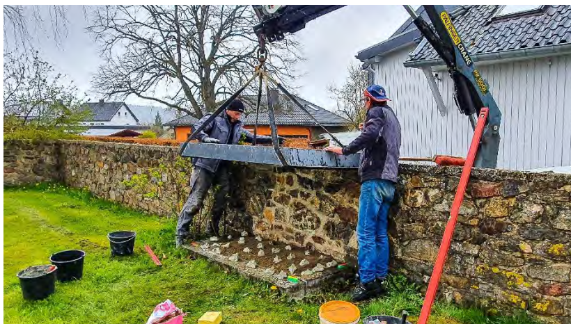
Bei der Rekonstruktion wird gerade (2021) die Grundplatte auf die Grabeinfassung gelegt.
