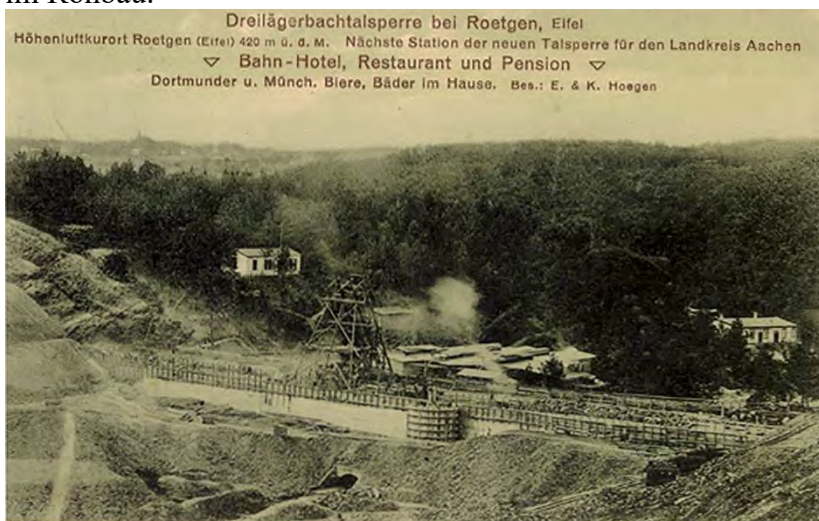
Die Talsperrenbaustelle mit der Gründung der Mauer vom Dreilägerbachtal aus gesehen: Sammlung Dreilägerbachtalsperre
