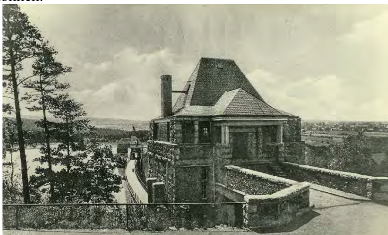
Die Entsäuerungsanlage, auch Kalkhäuschen genannt, um 1930
