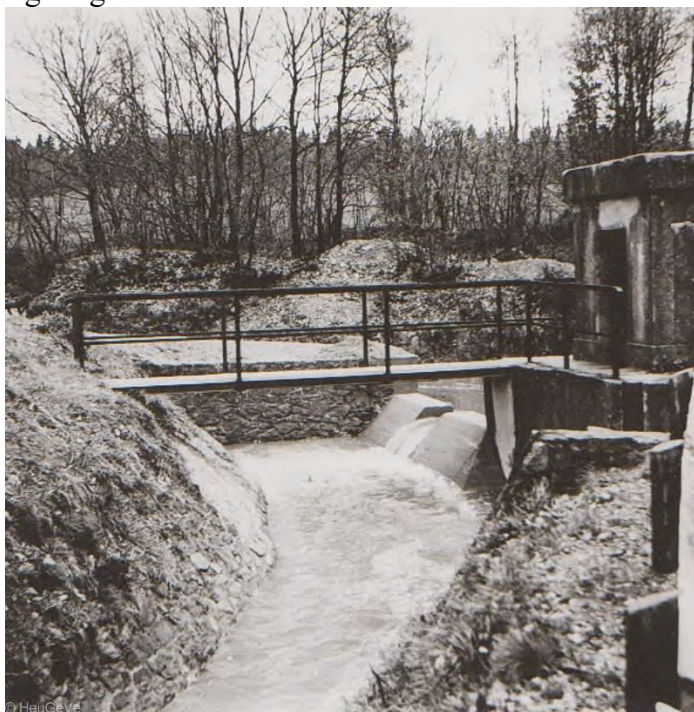
Hier zweigt seit 1922 der Schleebachgraben vom Schleebach ab.
