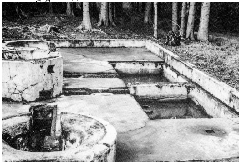
Überreste der Versuchsfilteranlage von etwa 1910 am Vorbecken, Foto aus „Roetgen wie es war“
