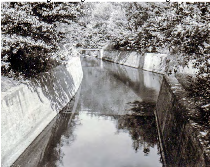
Überlauf der Dreilägerbachtalsperre um 1912
