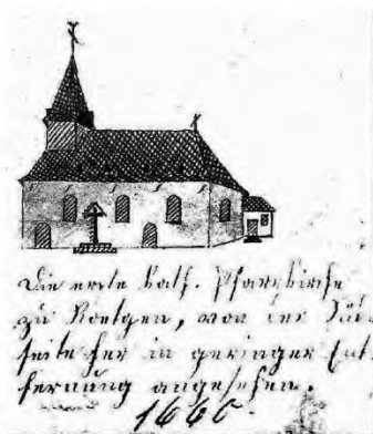
Die erste kath. Pfarrkirche zu Roetgen, von der Südseite her in geringer Entfernung angesehen.
