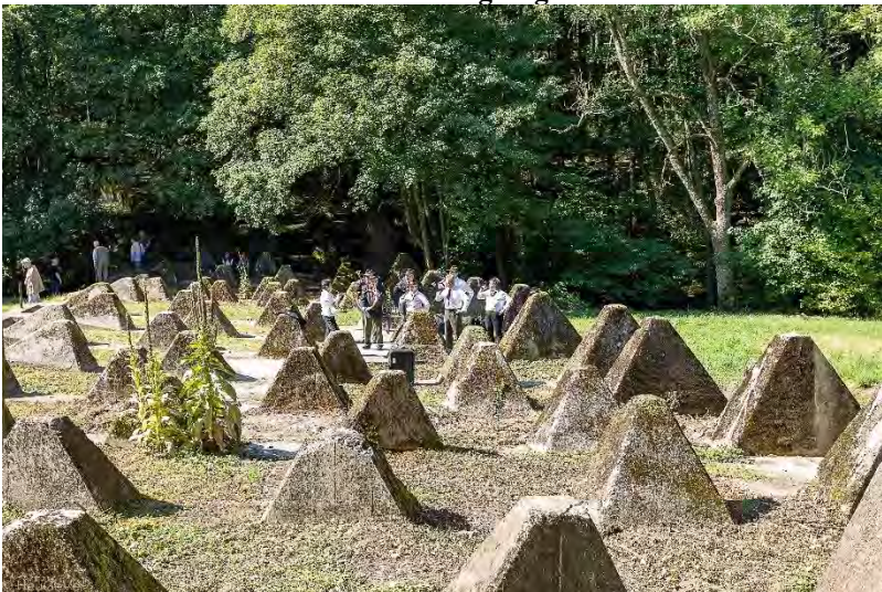
Die Jagdhornbläser hatten sich im hinteren Teil der Höckerlinie aufgestellt.
