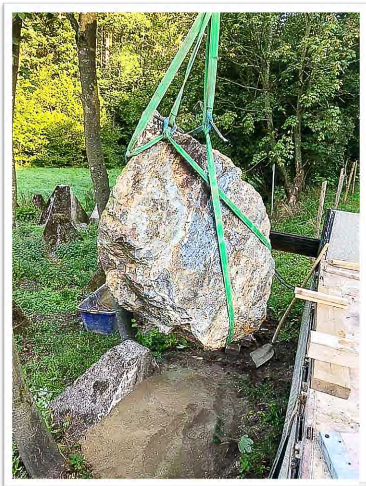
Der „Vennwacken“ wird am 23.08.2019 vor die Höckerlinie gesetzt.
