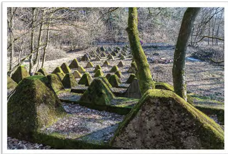
Nach getaner Rodungsarbeit ist die Roetgener Höckerlinie wieder auffindbar.
