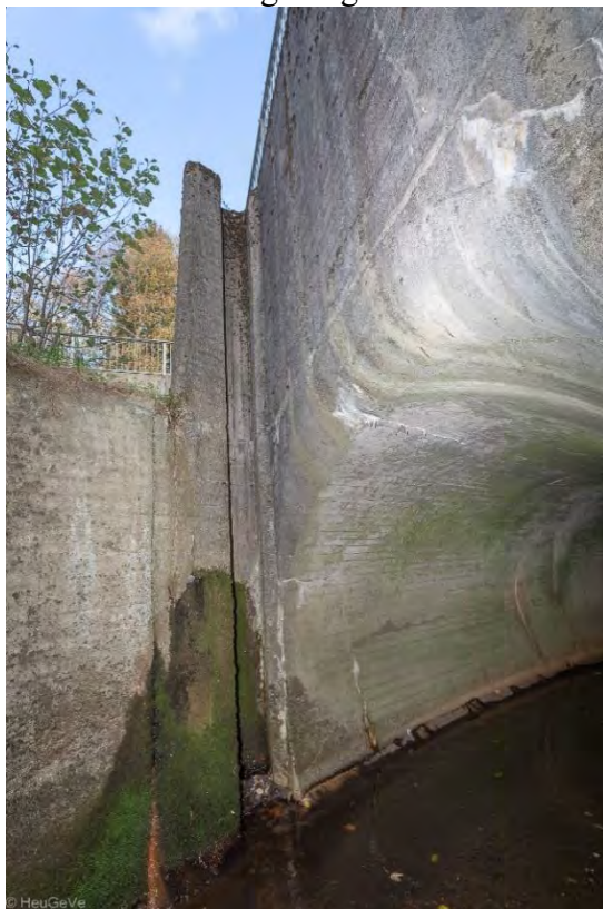
Eine Nut für die vorgesehene Balkensperre am Weserstollen
