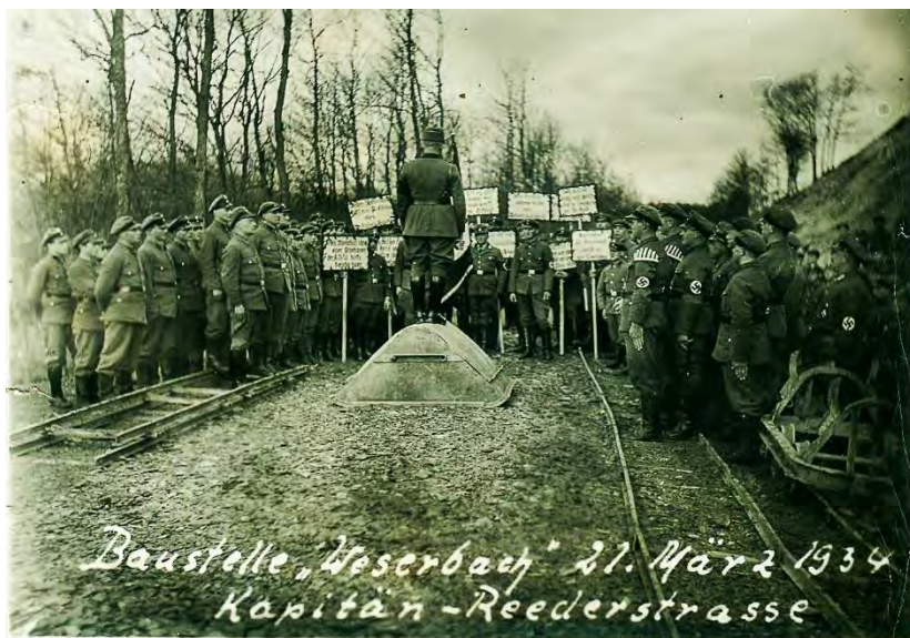
Die Baustelle am Weserbach nennt man „Kapitän-Reederstrasse“, 21.03.1934. Sammlung 2. WK in Roetgen
