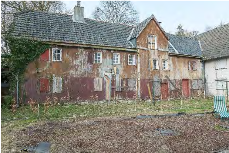
Gezeigt wird die Rückansicht des Hauses mit Zimmern auf 3 Etagen. Das Dachgeschoss hat Fenster am Südgiebel (links) und in der nach Osten gerichteten Dachgaube.
