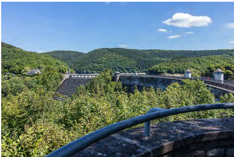
Überblick auf die Sperrmauer der Urfttalsperre, Foto HeuGeVe
