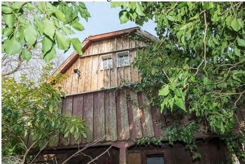
Giebel und Balkon an der Südseite des Denkmals, Foto HeuGeVe
