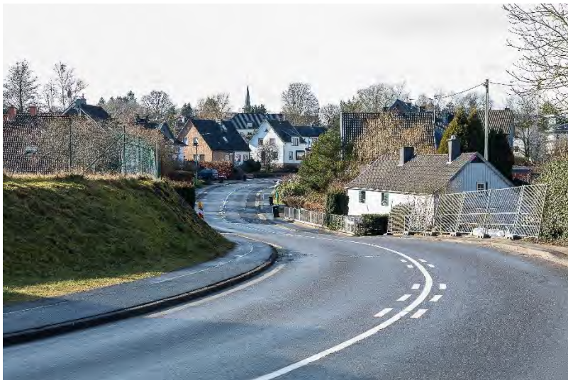
Der Abriss des Hauses Nr. 123 ist abgeschlossen.
