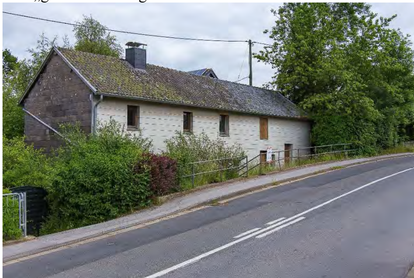
Das „Abrisshaus“ Hauptstraße 123, Foto 2014
