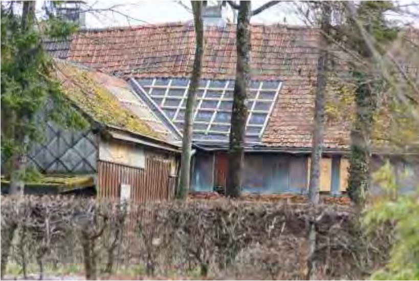
Notreparatur des Dachs nach dem Sturmschaden, 2017
