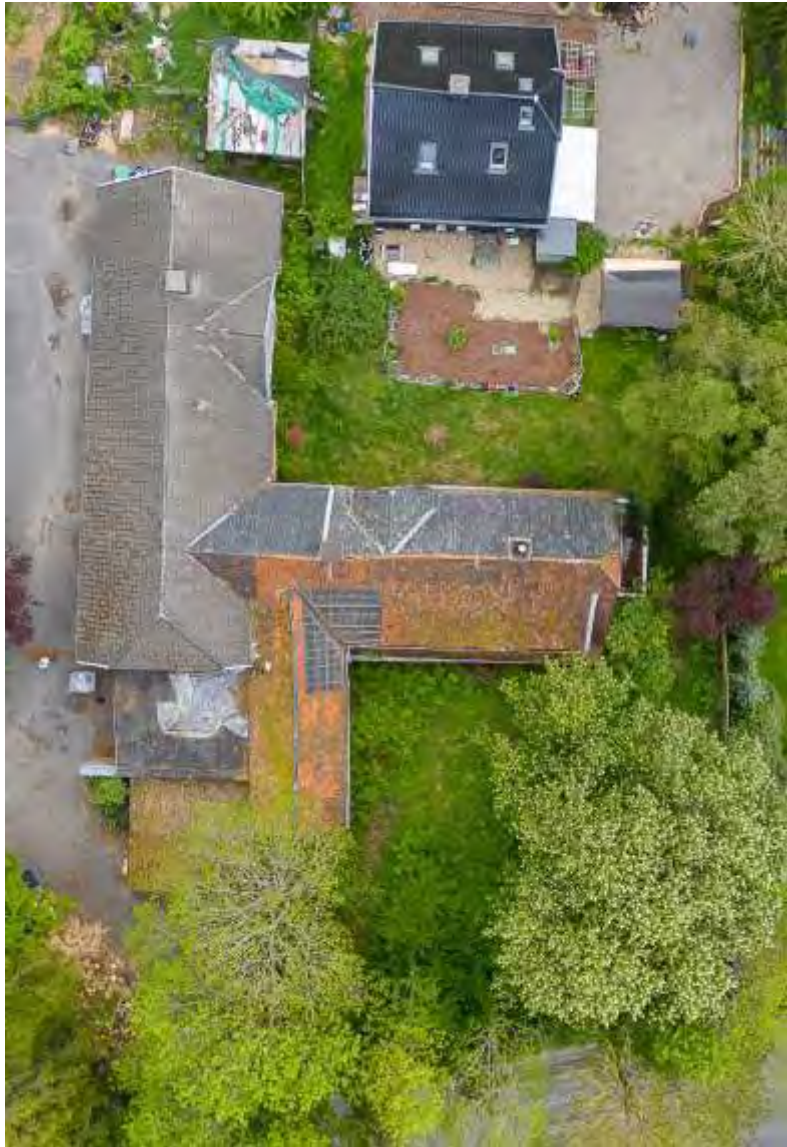
Aktuelle Luftaufnahme des Areals „Am Graben“
