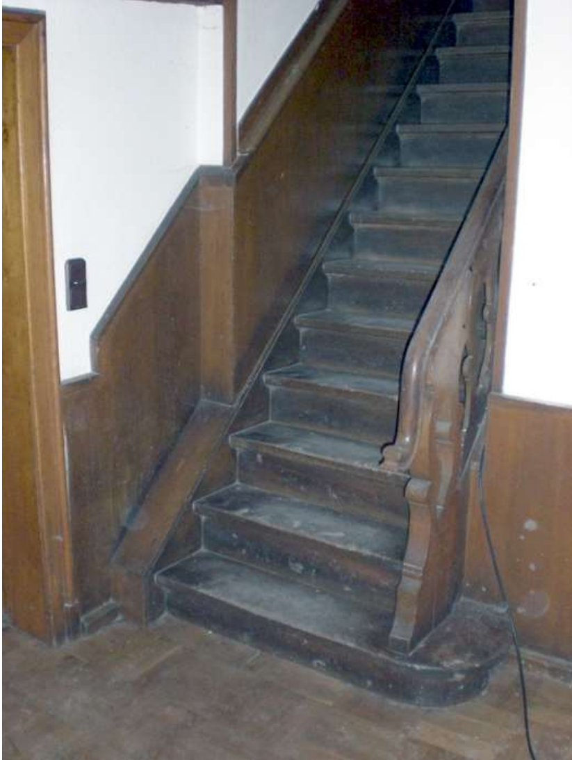
Gut erhaltene Eichentreppe
