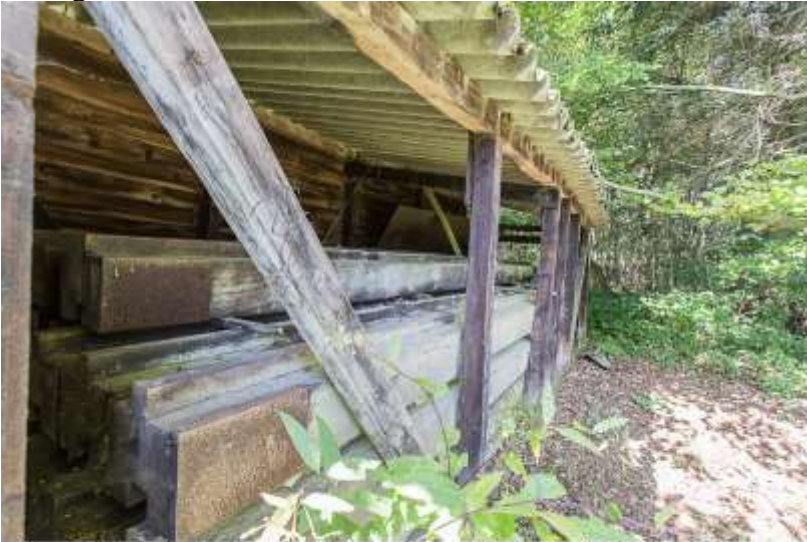
„Dambalken“ in der Mühlenstraße: Die in dem Unterstand gelagerten Planken können bei Hochwasser zum Absperren des Weserstollens benutzt werden. Roetgen, Charliers Mühle
