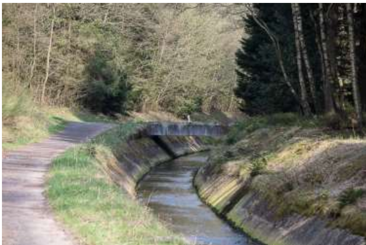
Der Weser-Umflut-Kanal südlich von Schwerfeld
