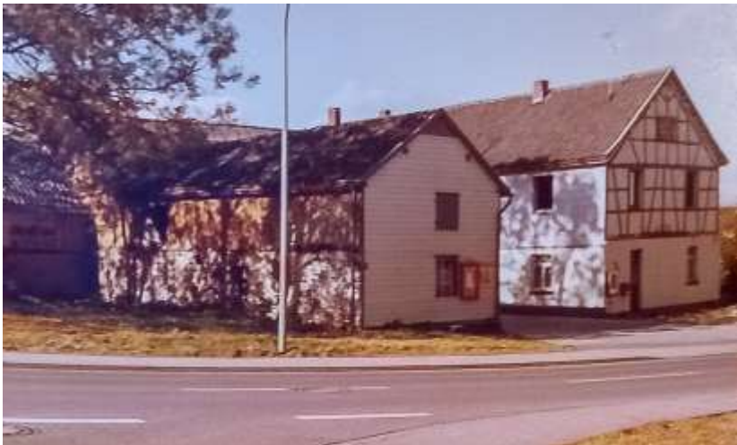
Der linke giebelständige Anbau, wo die Waschgelegenheiten waren.
