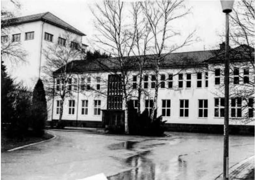
Das Filterhaus des Wasserwerks im Landkreis Aachen in Roetgen an der Dreilägerbachtalsperre „Roetgener Schleife“ HeuGeVe: 85-9
