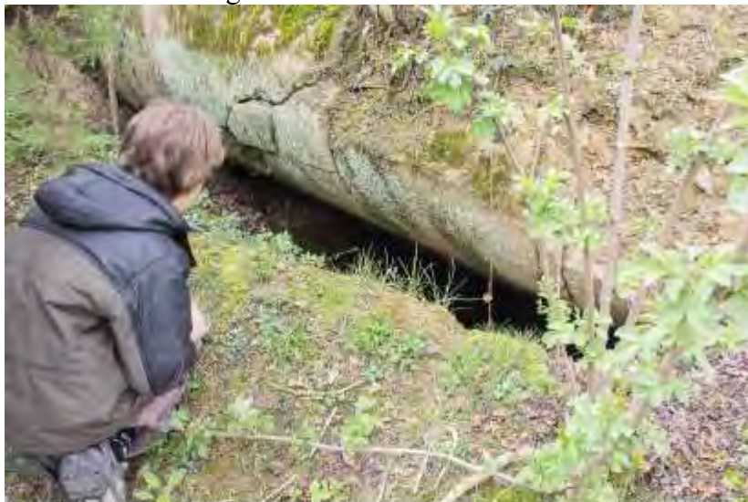
Unterstand D43, Typ 101, im Jahre 2012, auf dem Gelände des Filterhauses gelegen Roetgen, Westwall
