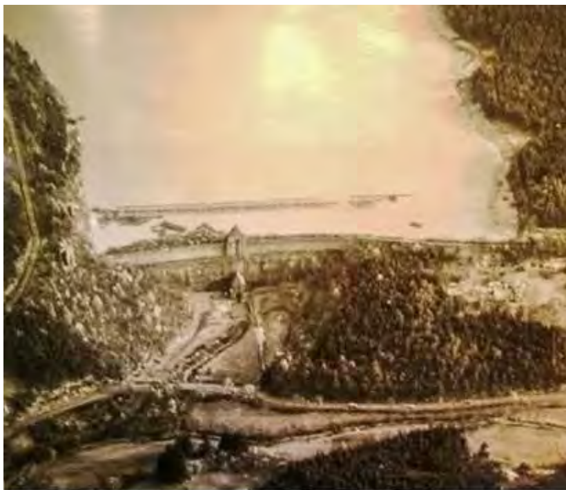
Die Mauer der Dreilägerbachtalsperre im 2. Weltkrieg, man erkennt das Torpedonetz vor der Mauer. „Roetgener Schleife“
