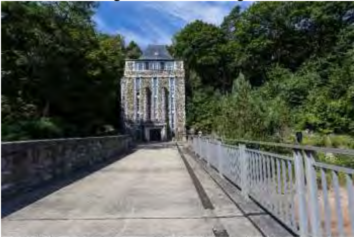
Das „Kalkhäuschen“, die ehemalige Entsäuerungsanlage, auf der Mauer der Dreilägerbachtalsperre, 2016 Roetgen, Dreilägerbachtalsperre
