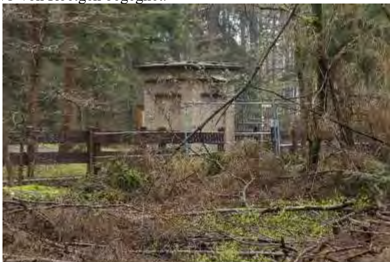
Das Pegelhäuschen des Hasselbachgrabens an der K24, das abgeleitete Wasser fließt in die Dreilägerbachtalsperre, „Roetgener Schleufe“
