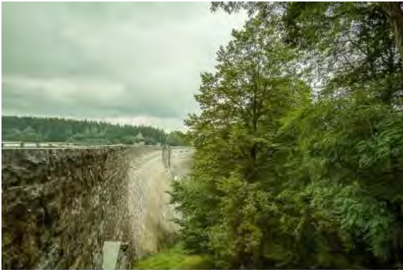
Blick über die Mauer der Dreilägerbachtalsperre von Norden gesehen Roetgen, Dreilägerbachtalsperre
