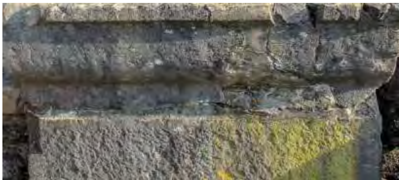
Mehrfach zerbrochene Basisplatte
