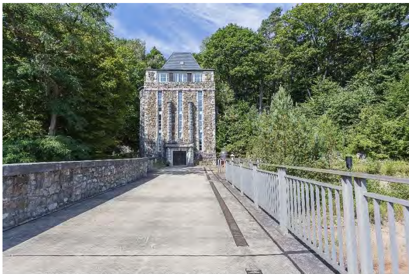
Das „Kalkhäuschen“ 2017, die alte Entsäuerungsanlage der Dreilägerbachtalsperre von 1912 • IHeuGeVe: 90-0
