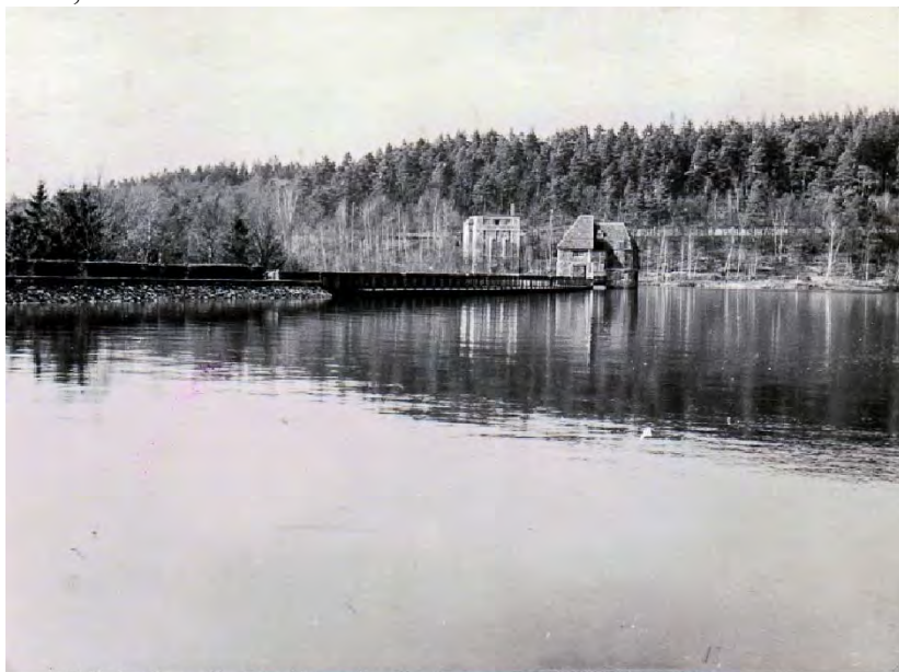
Blick über die Dreilägerbachtalsperre, 1950. Man erkennt das Kronenhaus und das „Kalkhäuschen“. • HeuGeVe: 90-9
