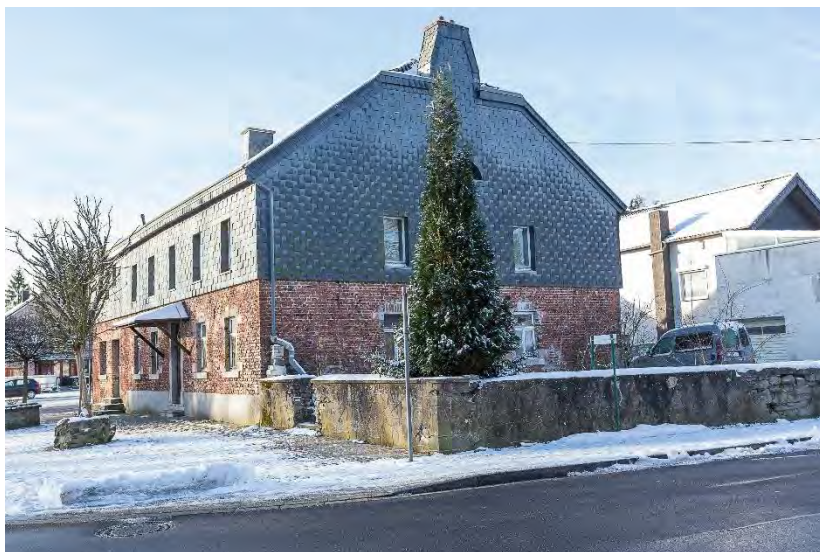
Der Grenzhof an der B258/Raerener Straße im Winter 2015/16
