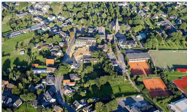
Luftbild des Ortszentrums mit Schulbaustelle im Juli 2009 • HarzGaleri 2102
