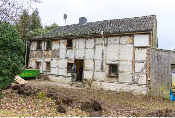
Bereits am Ende des 18. Jahrhunderts stand in der Offermannstraße 16 ein Haus; Teile davon sind noch erhalten, soweit man im Inneren sehen kann. Wir werden den Umbau verfolgen und dokumentieren.
