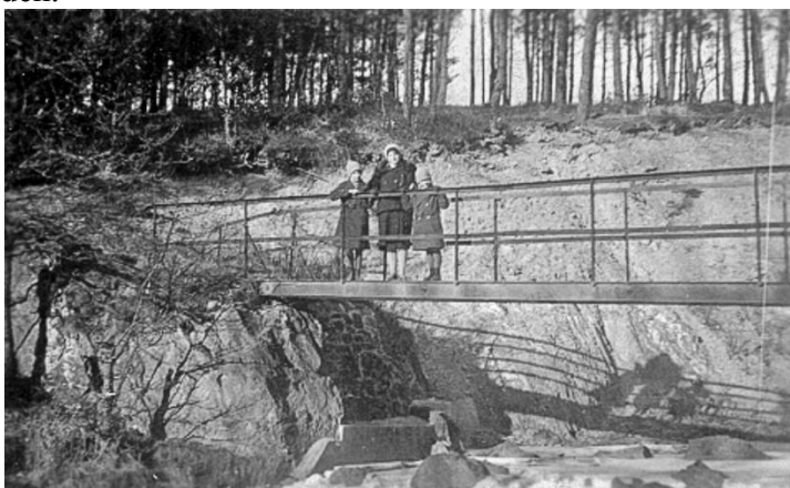
Die Münsterbrücke im Februar 1933; man sieht die intakte Stahlkonstruktion der Brücke. Roetgen, "Münsterbrücke"
