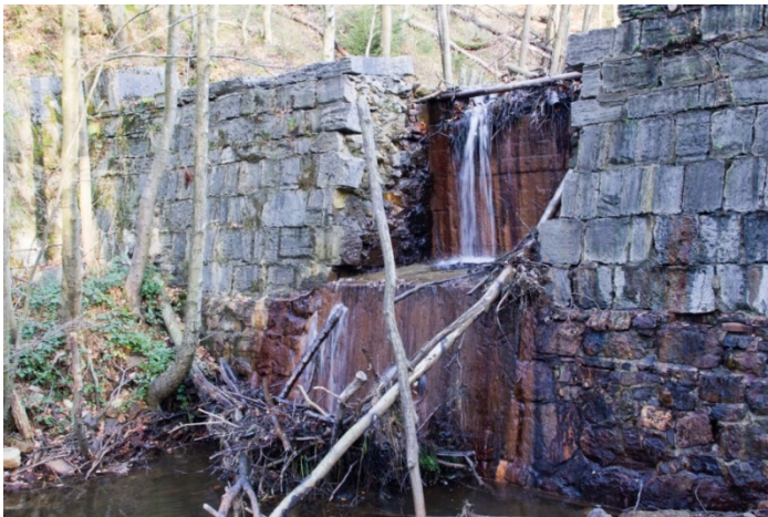
1983 zerstörten die Belgier die Mauer der Wesersperre; später wurde die Lücke teilweise wieder geschlossen, um wieder Wasser anzustauen. Roelgen, "Belgisch Bassengsche"
