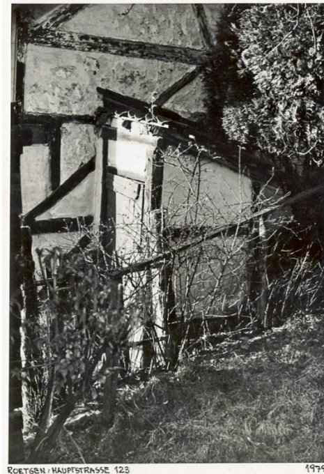
Scheißhaus, Foto 1979 Roetgen, Hauptstraße
