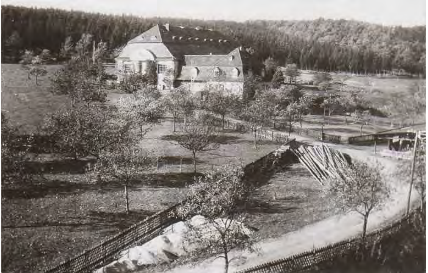
Das „alte Filterhaus“ vor der Zerstörung am 12.09.1944
