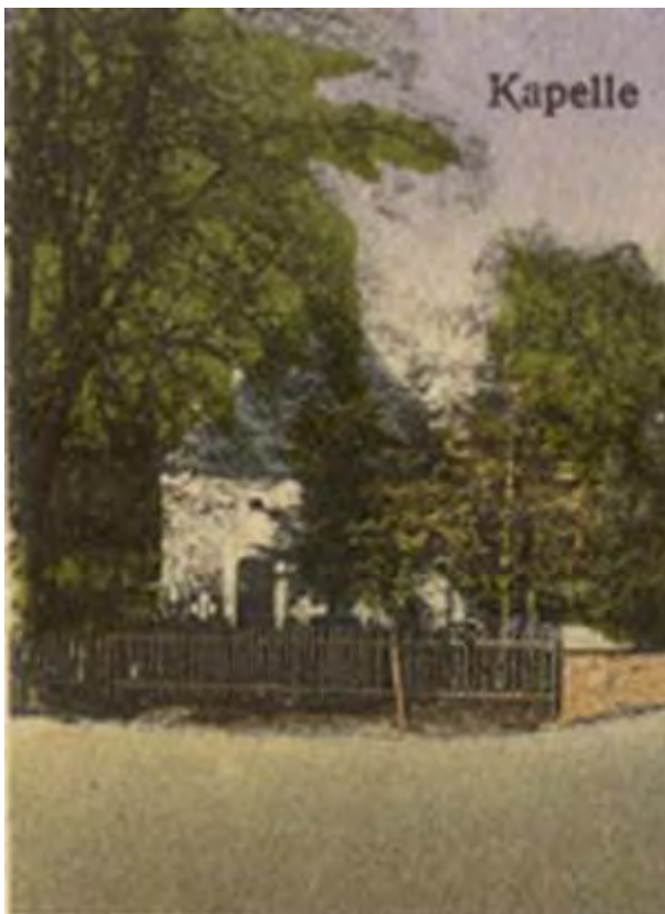
Abb. 58: Dieser zugegebenerweise schlechte Ausschnitt einer Postkarte aus den 30er Jahren zeigt den Eisenzaun, mit dem man für einige Jahre die Umfassungsmauer ersetzte.
