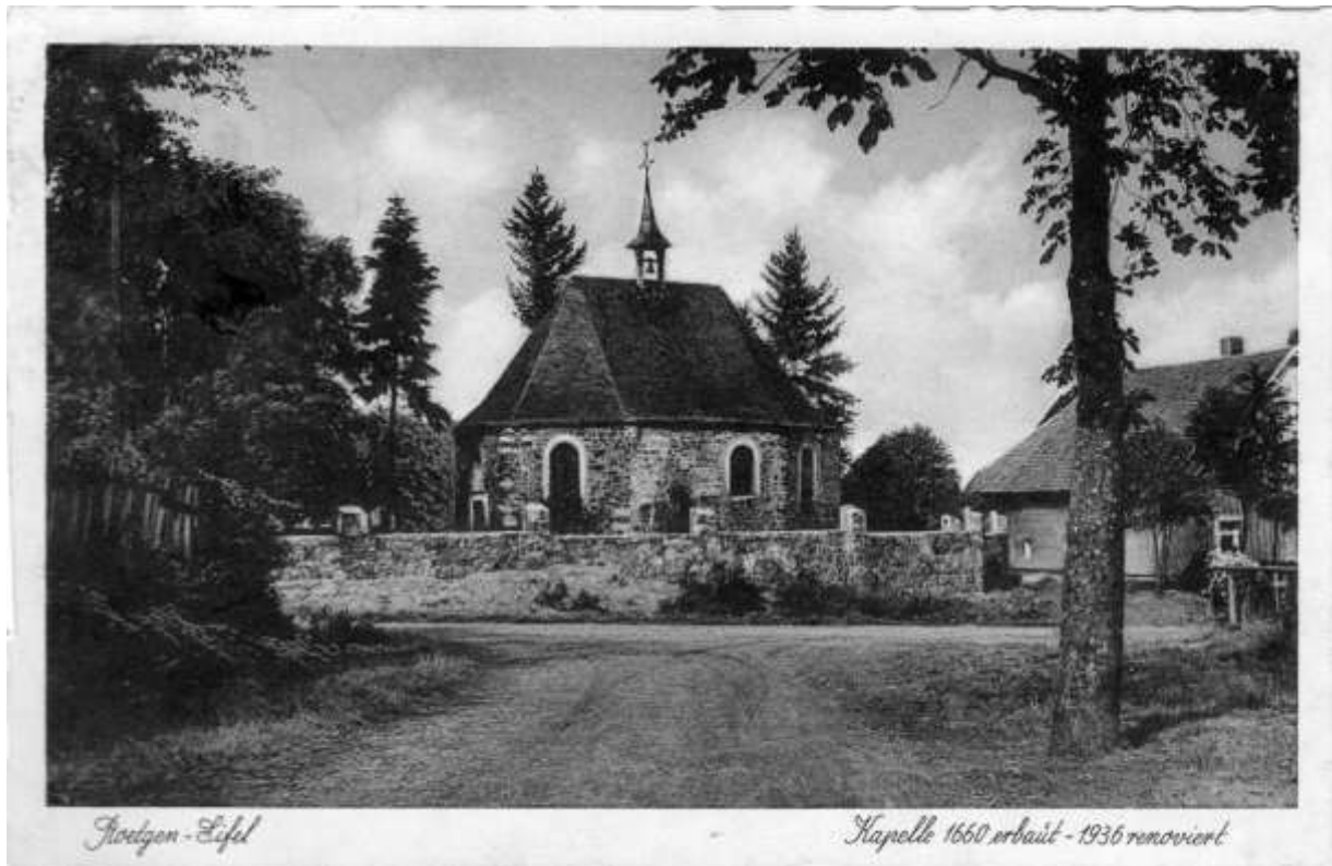
Abb. 66: Unsere Kapelle einmal wieder als Postkartenmotiv. 1936 wurde der Eisenstaketenzaun wieder durch eine Bruchsteinmauer ersetzt. Die Zinnen der Mauer waren einst als Kreuzwegstationen gedacht, wurden aber nie als solche eingerichtet.
