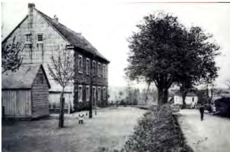
Abb. 57: Blick von der Hauptstraße auf Kapelle und Schule
