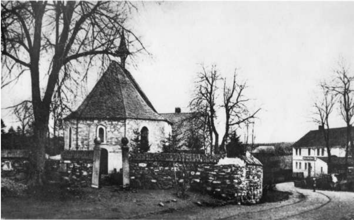
Abb. 54: Das Bild zeigt die Marienkapelle um 1910. An der Umfassungsmauer kann man erkennen, in welchem marodem Zustand sich die Bausubstanz befindet. In späteren Jahren wurde die Mauer mehrfach geändert und versetzt. Die Linde steht heute innerhalb der Kirchhofsmauer.
