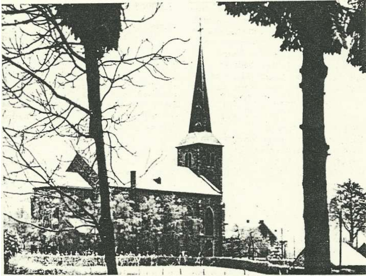
Die kath. Pfarrkirche in Roetgen
